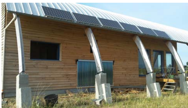
Maison autonome dans le Gers. Ossature bois en autoconstruction partielle.
