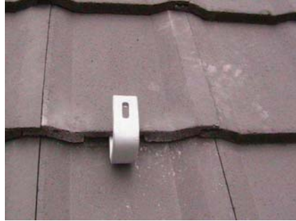
Vue après pose de la tuile
