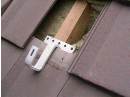
Pose des crochets
