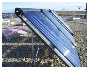
Montage avec supports terrasse
