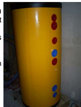
Face arrière du ballon. Points de connexion des différents réseaux (ici un ballon à 2 échangeurs).
