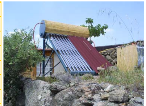
BASIC90 en été dans le sud; l'utilisateur masque la moitié des tubes.
