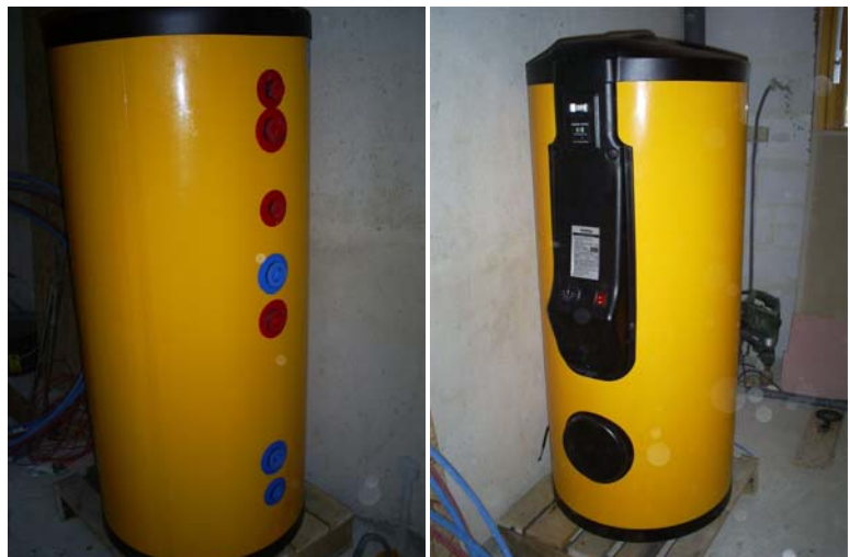
Vues des deux faces d'un ballon: face connections et face tableau de contrôle.
