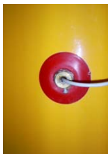
Doigt de gant avec sonde de température.
